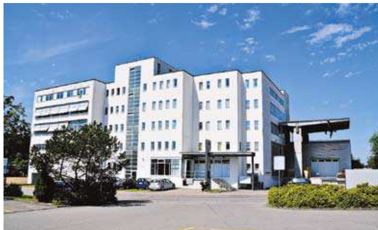
An der Grindelstrasse 12, direkt gegenüber des Tenniscenters Grindel, soll eine der grössten Boulderhallen der Schweiz entstehen.
